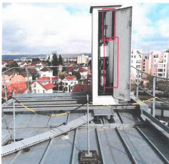
Vue de la terrasse S0 après travaux
