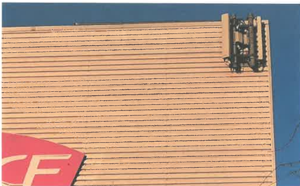
Vue de la terrasse S0 avant travaux
