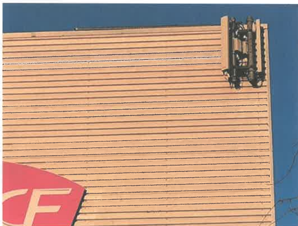
Vue de la terrasse S1 avant travaux
