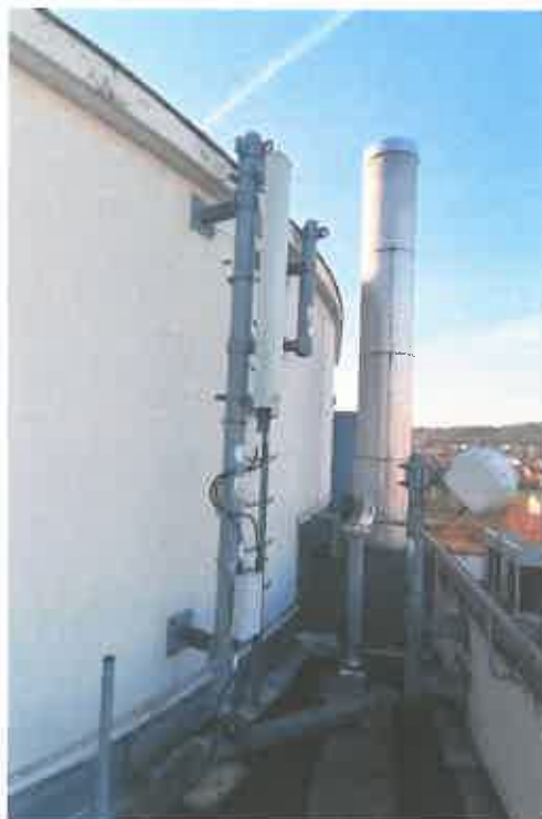
Vue de la terrasse S2 avant travaux
