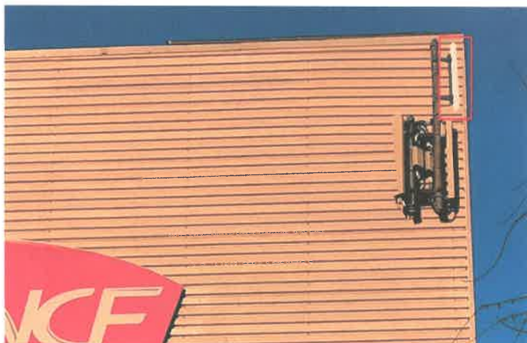
Vue de la terrasse S0 après travaux
